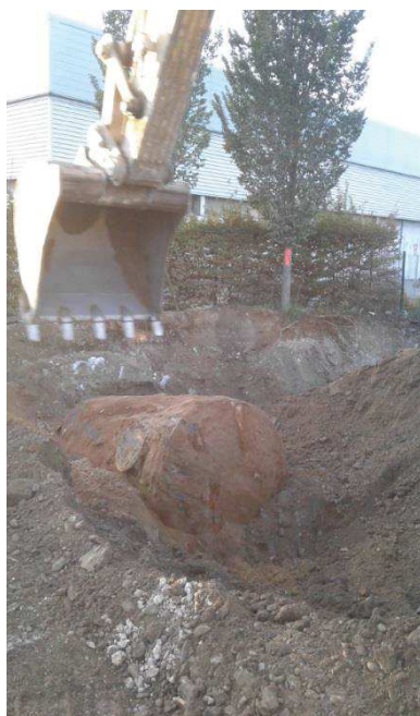
Découverte et retrait d'une seconde cuve enterrée localisée au centre de l'emprise de la zone polluée
